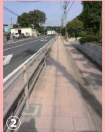
金崎 県道にガードレール設置
