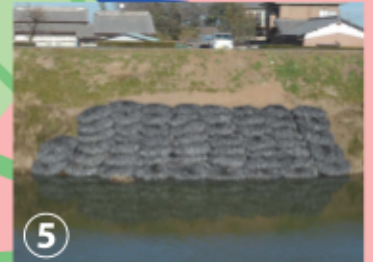
赤崎 中川の土手破損につき改修
