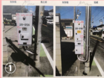
西宝珠花 信号機制御ボックス薄型へ取替
