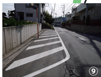
東中野＝川辺小東側、道路 整備
