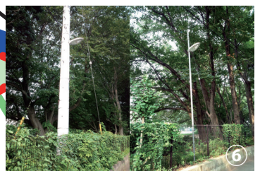
大倉＝桜川小東側、街灯設置
