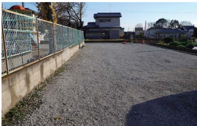
■2013年12月 東中野 庄和第二保育所駐車場内道路整備
