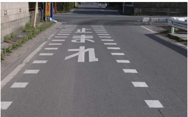
■2013年3月 永沼579 市道に「止まれ」の道路標示を設置
