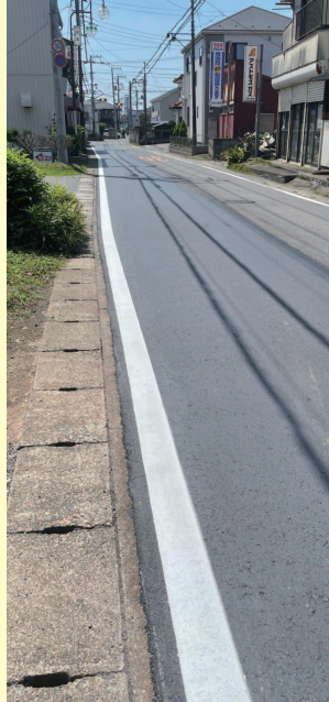
2024年7月 西金野井 1884 道路補修
